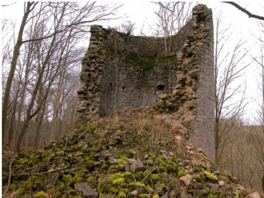
La tour-réservoir de la machine de Modave Etat actuel — Vue côté sud On aperçoit ici très bien dans le parement intérieur les emplacements des poutres qui soutenaient vraisemblablement le réservoir en bois de cet ancien « château d'eau ».
