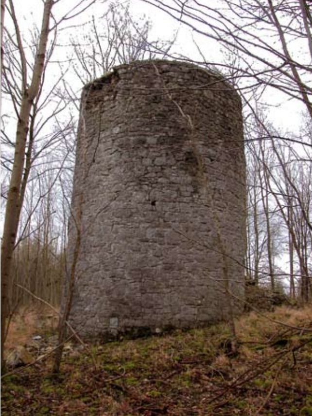
La tour-réservoir de la machine de Modave Etat actuel — Vue côté nord
