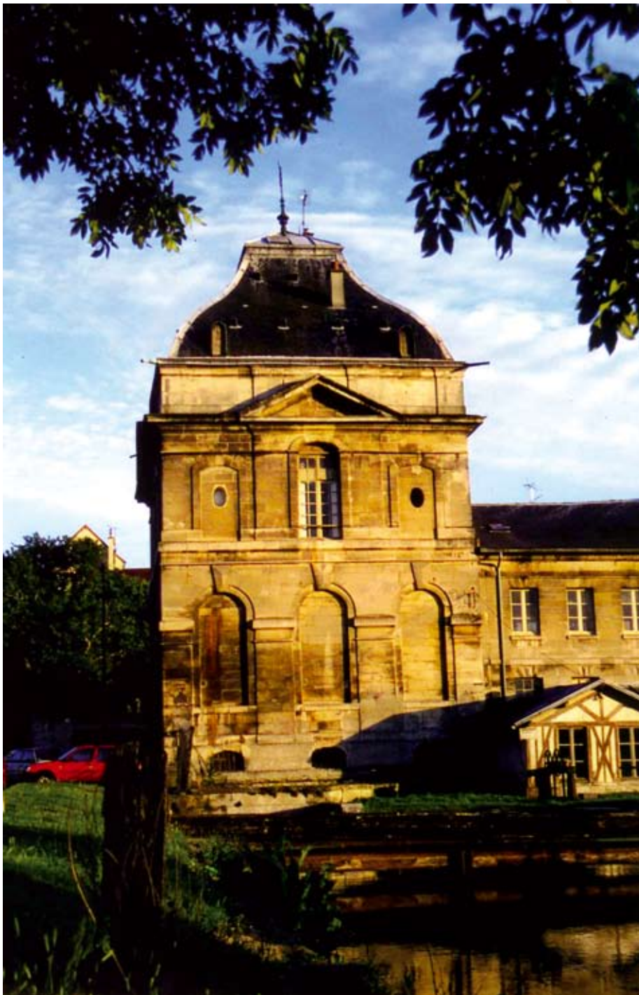
PAVILLON de MANSE (cliché Eric Soullard). Le pavillon de Manse, construit en 1678 par Jules Hardouin-Mansart pour le Grand Condé, afin d'abriter la machine de Jacques de Manse pour les grandes eaux des jardins de Chantilly.
